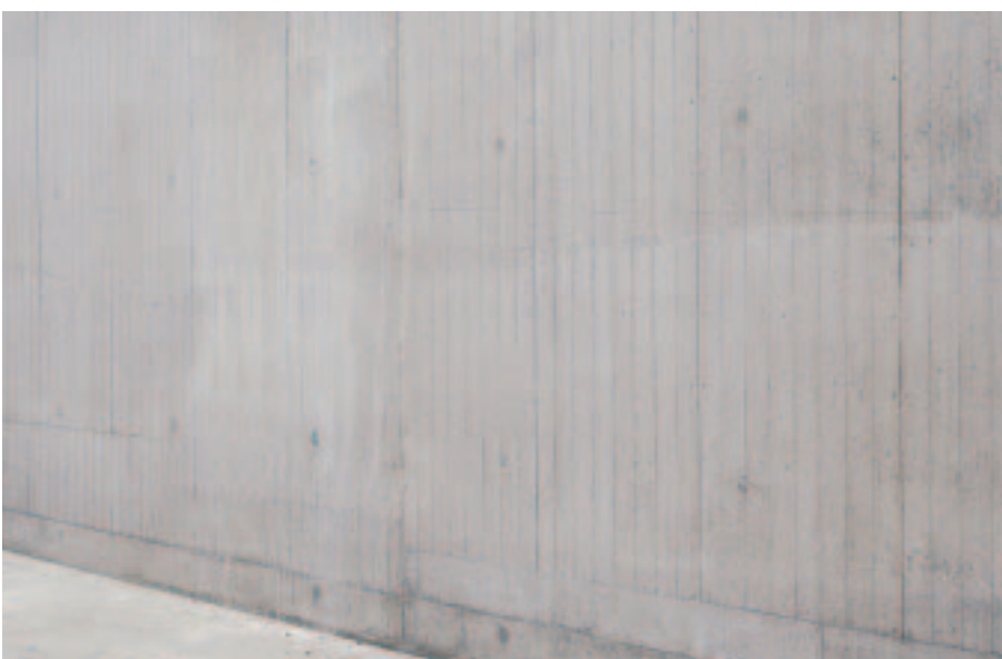
Färdig vägg med inlimmade betongkonor.
