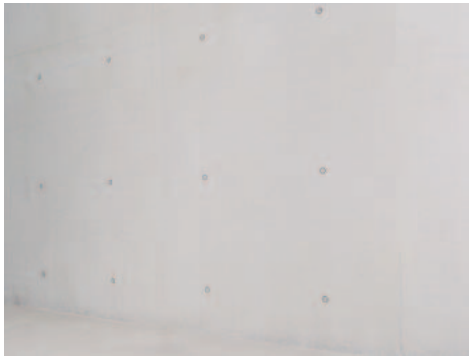
Inlimmade betongkonor med skuggfog
