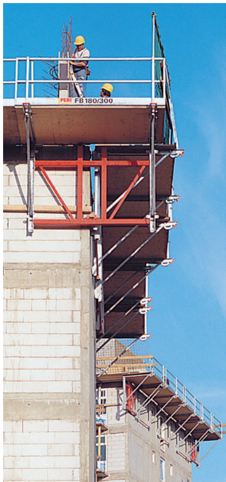
Användning som hörnbrygga på höger sida.
