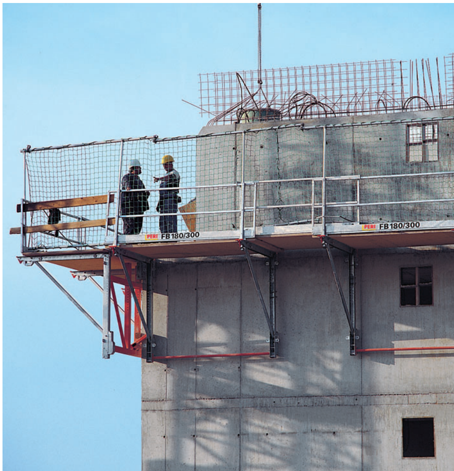
Fasadbrygga FB 180-3 med skyddsnet använd som takfotsställning.
