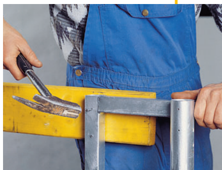
Spikhålen på skyddsräckesramen gör det enkelt att sätta fast skyddsräckesplankorna.
