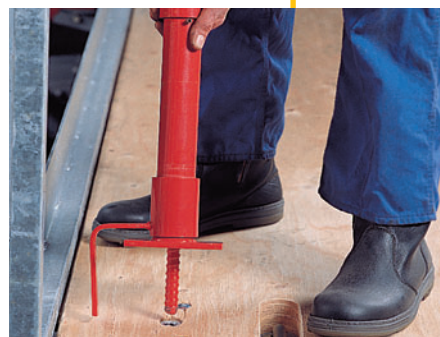
Räckesstolpe FBP som ska ta upp skyddsräckesplankorna på plats, skruvas fast i universalfäste (DW 15).
