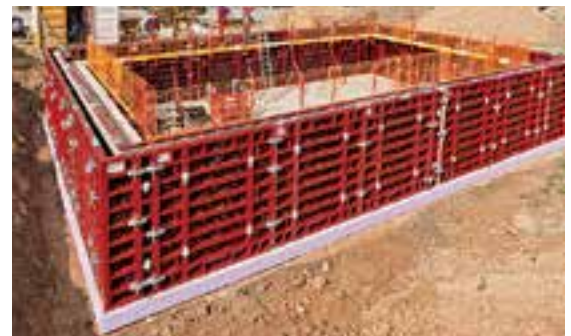
Kort byggtid – hög säkerhet. MAXIMO och PROKIT sidoskyddsgaller på gjutkonsoler. Villakällare, Weißenhorn
