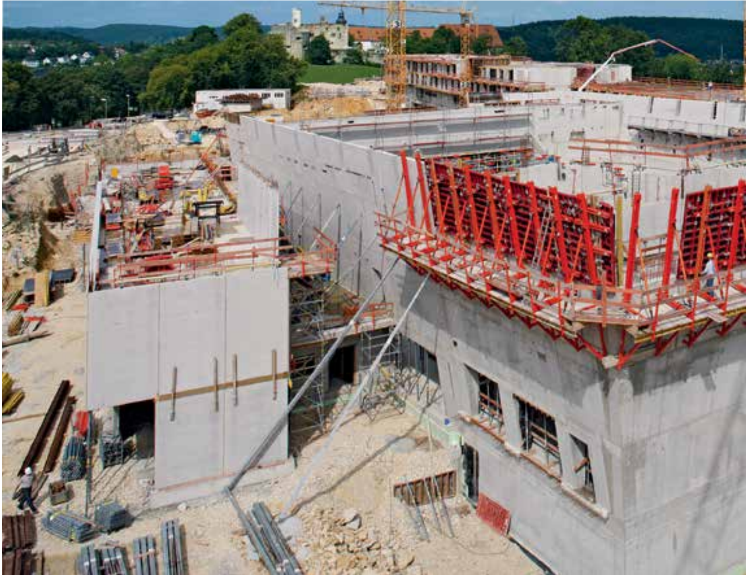
Kort byggtid – hög säkerhet. MAXIMO och PROKIT sidoskyddsgaller på gjutkonsoler. Villakällare, Weißenhorn
