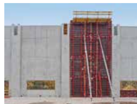
Trefaldigt påskarvad och flyttad i sin helhet – inget behov av arbetsställning på motstående sida. Övningscenen Stadsteatern, Stuttgart
