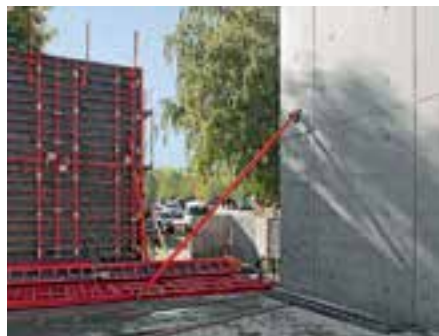
Regelbundna elementfogar och formtagshål på synliga väggtytor. Varuhuset Outlet-Center, Metzingen
