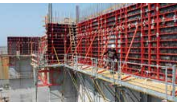
MAXIMO i klätterfunktion på Fasadbrygga FB 180. Siemens Logistikcentrum, Frankfurt
