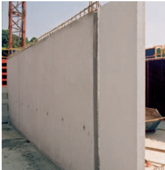
Stora betongytor med hög finish direkt efter formrivning.
