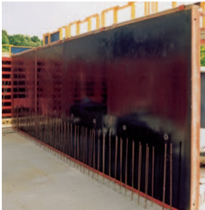
5,4 m långt element med stor yta, med endast ett formstag på 2,7 m höjd.
