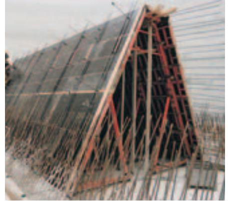
Trapetsformad tunnel med TRIO och stödbock SKS.
