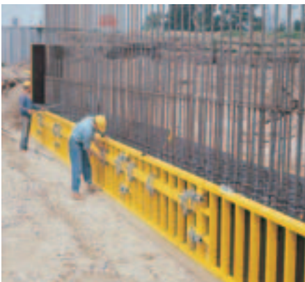
TRIO-L vid fundamentformsättning.
