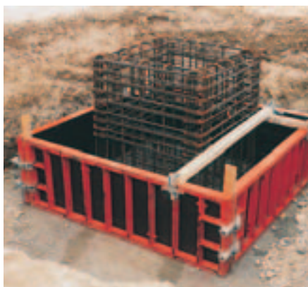
Liggande användning av elementen för fundament.
