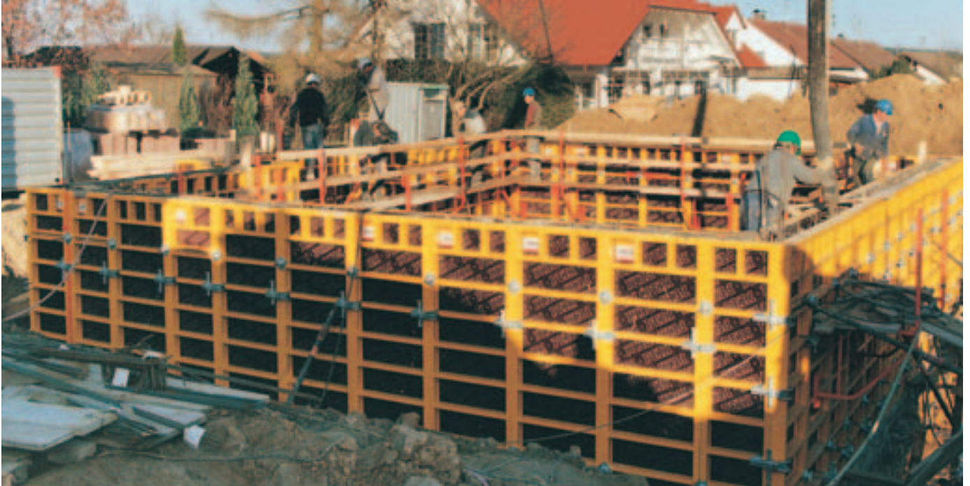
Hel småhuskällare formsatt med TRIO-L oberoende av kran.
