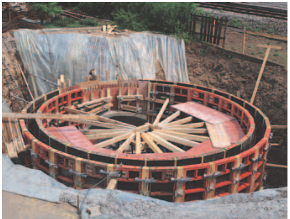
Avloppsverk formsatt med TRIO element TR 270 x 60.
