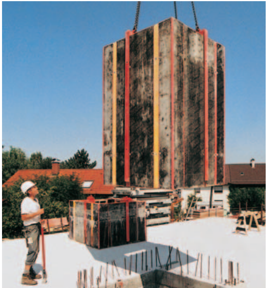
Komplett schaktform hängande i kranen.
