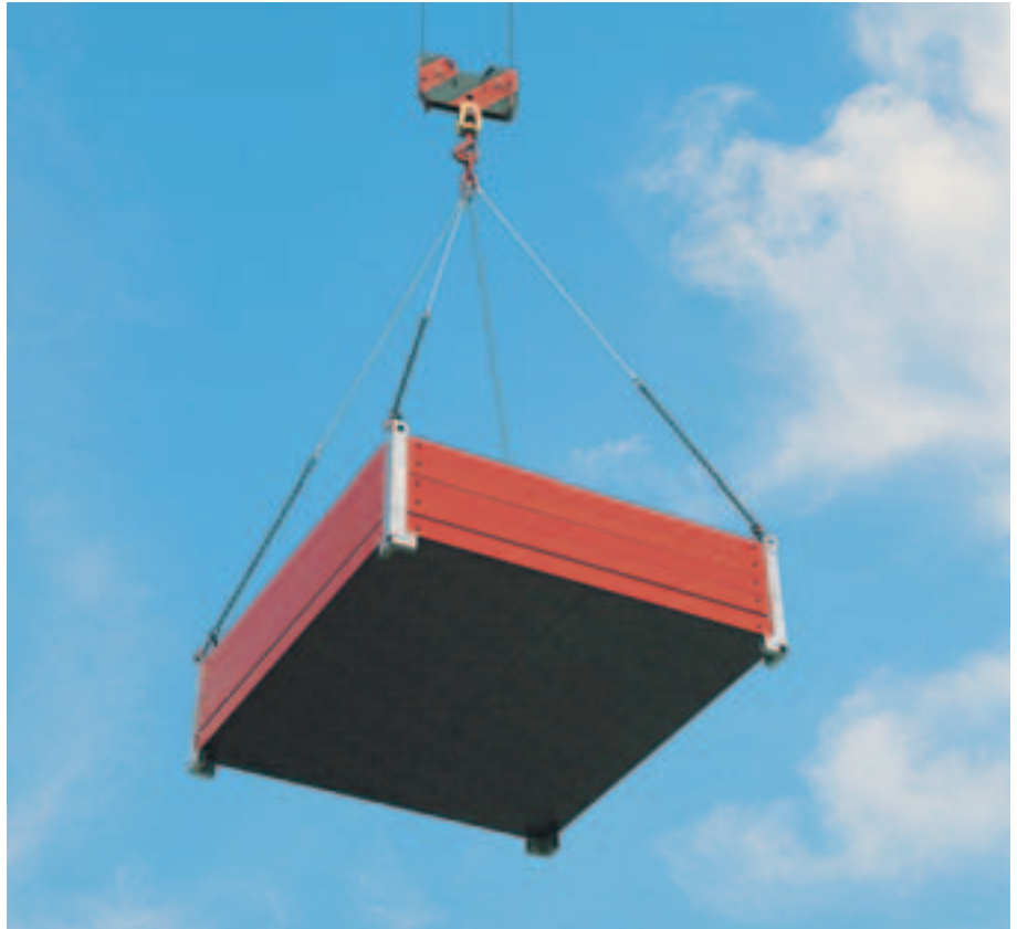
Transport av elementstapel med galvaniserat TRIO stapelstöd och TRIO kombilänga.
