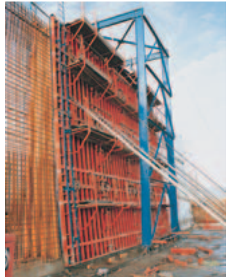
Komplett TRIO enhet 8,40 m hög. Inner- och ytterform upphängd på körbar portalställning.
