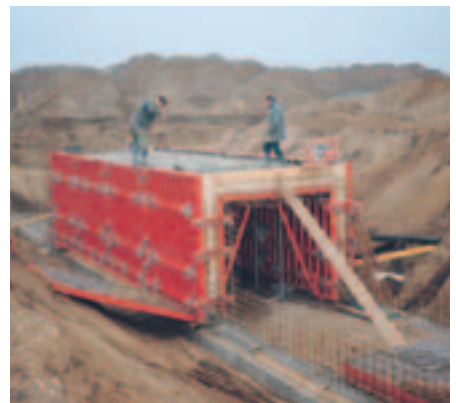
Rektangulär tunnel med TRIO standarddelar.
