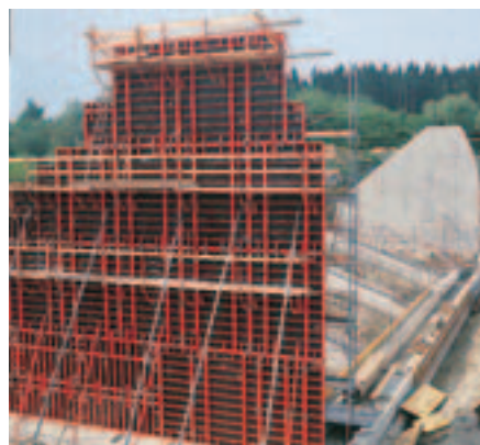
13,20 m hög vägg
