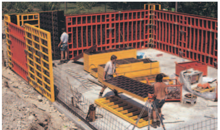
Bygge med TRIO-L alu och TRIO-stål. Hörn och passningar formsätts för hand med TRIO-L. Kranen behövs endast för storelementet 270x240 i stål.
