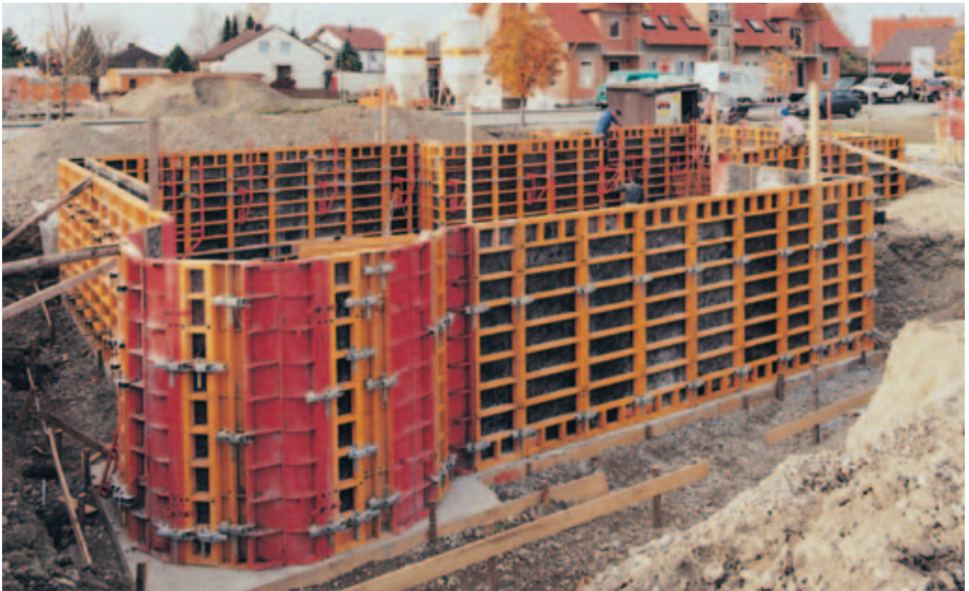
4 olika elementbredder med höjd 270 cm och 90 cm står till förfogande inom TRIO-L.
