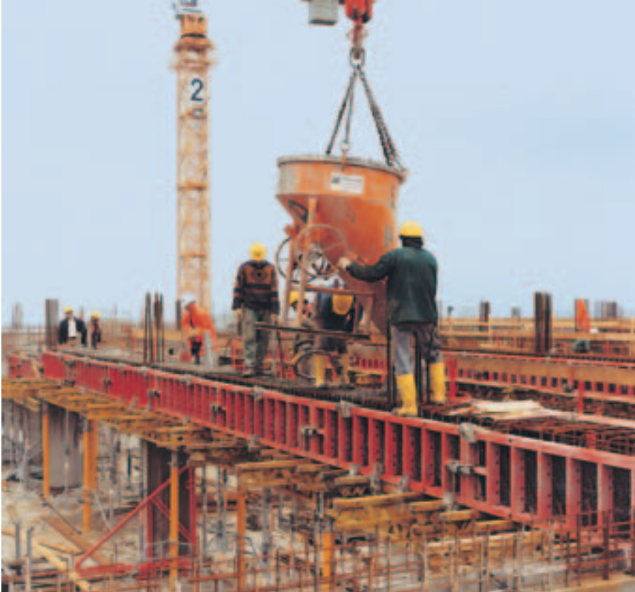
Mindre balk formad med TRIO. Understödning med MULTITROP-stämp.
