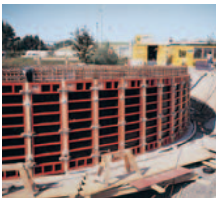
Standardelement för runda byggnader.
