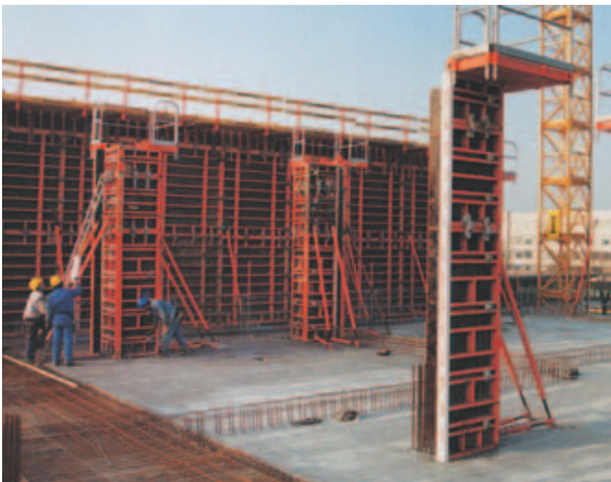
TRIO pelarform påbyggt till 4,50 m höjd, med gjutbrygga.
