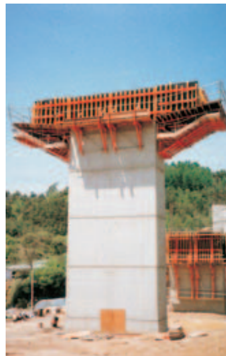
PERI stödbockar SB-2 som stödkonstruktion för formsättning av pelarhuvud.
