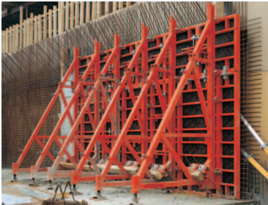
Stödbockar SB-B och C med elementform TRIO, formhöjd 3,90 m.
