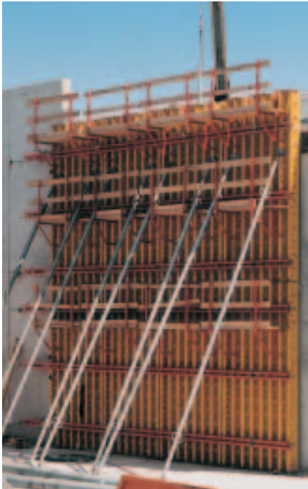
Påskarvat VARIO GT 24 element vid bygge av förvaltningsbyggnad.
