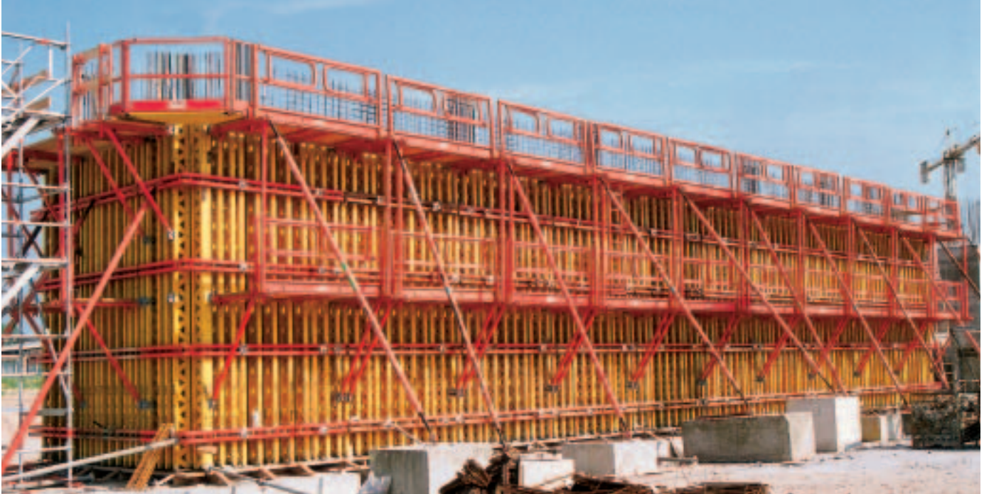
6,00 m hög VARIO GT 24 med standardelement med plattformar.
