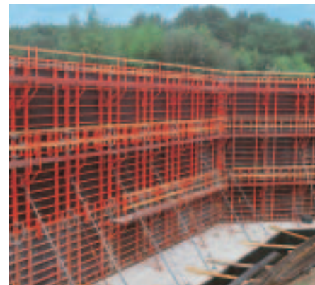
TRIO vid industribygge
