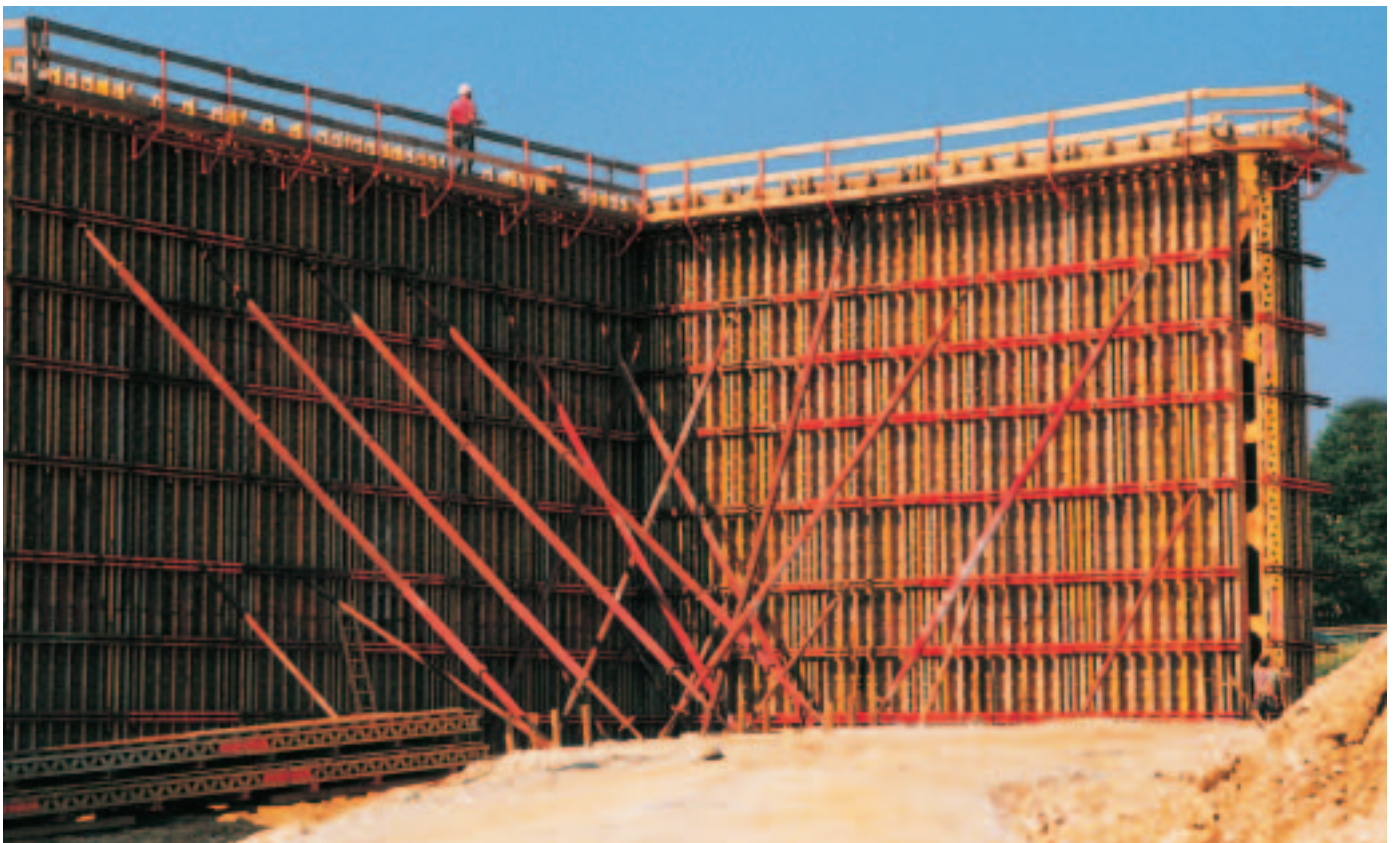
11,00 m högt brofäste med påskarvade balkar och extra ytterbalkar som förstärkning
