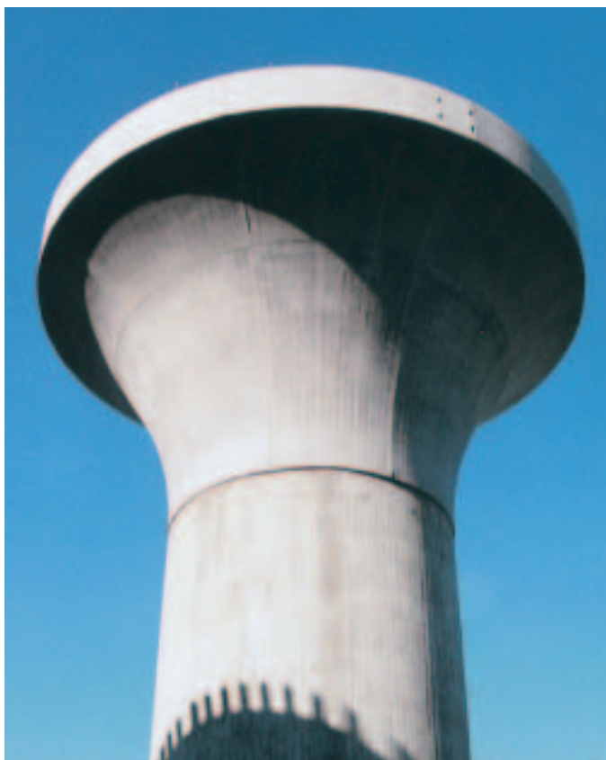
Bro över Triebischbach, BAB4. Max 49 m hög rund pelare med trumpetformade pelarhuvuden.
