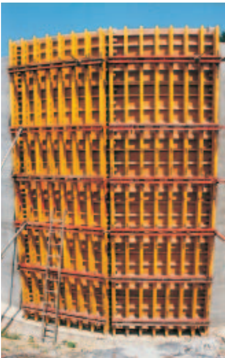
7,50 m hög rundform med formsågat virke på GT 24 balkar.
