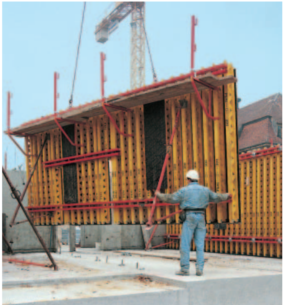
VARIO element med påmonterade gjutbryggor och formstöd flyttas som en komplett enhet.
