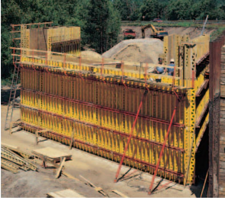
Brofästen med VARIO standard-element och anpassning på byggplatsen. Tremotorvägskorsning Wittstock, BAB 24
