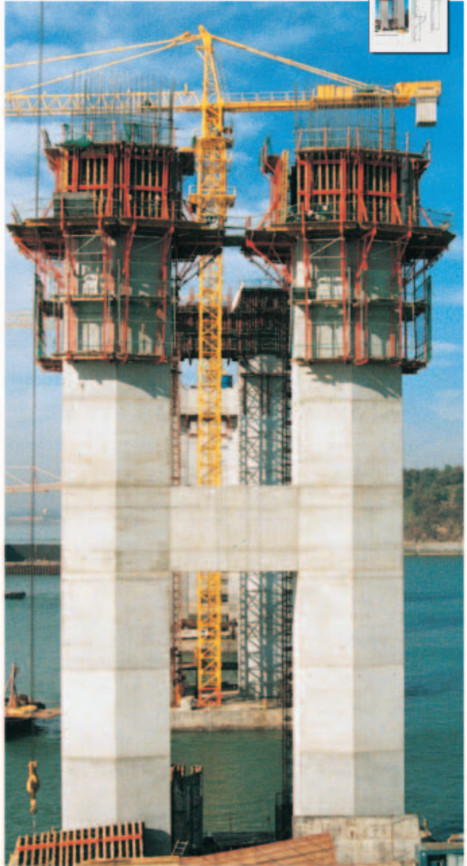
CB 240, klätterkonsol för problemfritt arbete före och efter formbyggnaden.
