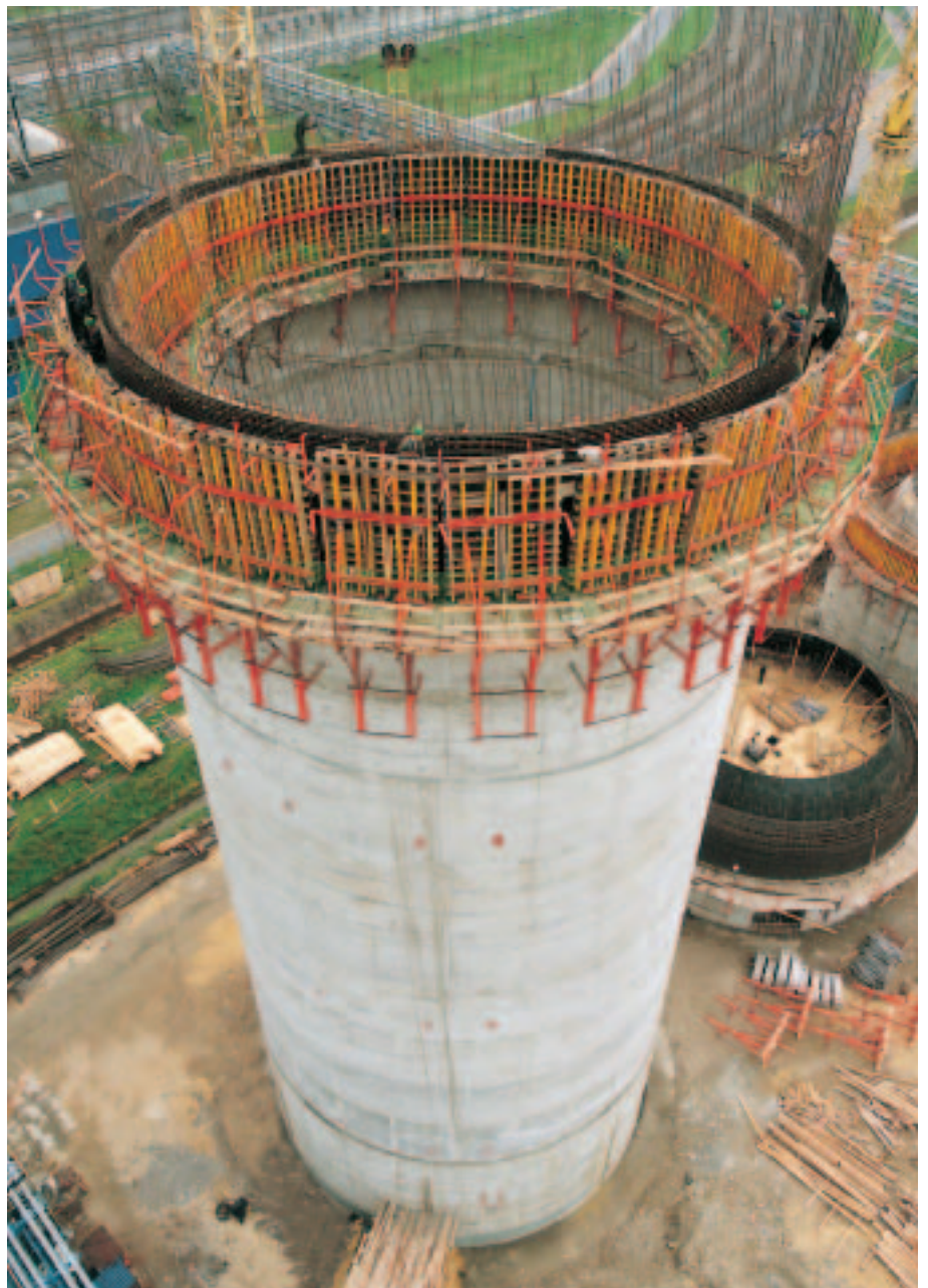
Silo, h = 72 m, \varnothing = 20 m vid kraftverket i Oppeln, Polen. Formad med rund VARIO balkform på klätterställningen KGF.
