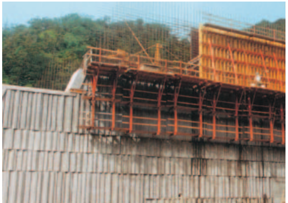
Portal till ett tunnelbygge på Hawaii. Utformning med VARIO GT 24 på klätterställning KGF 240
