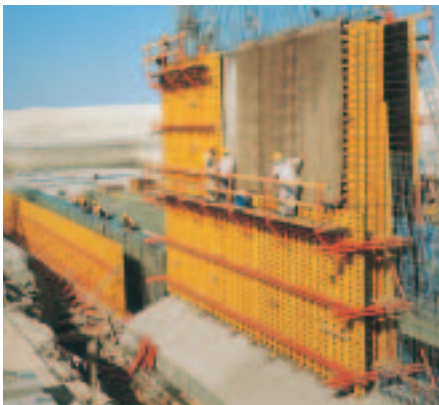
VARIO GT 24 vid bygge av ett reningsverk med koniska väggar.
