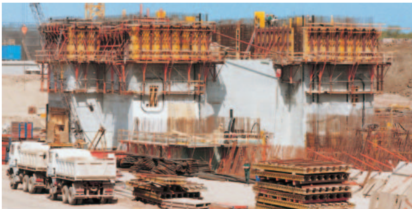
Komplett enhet: VARIO GT 24 på enkelsidig klätterställning SKSF 240.
