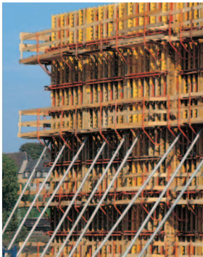
En gjutbrygga i enlighet med bestämmelserna med PERI gavelräcke 55 art.nr 065066
