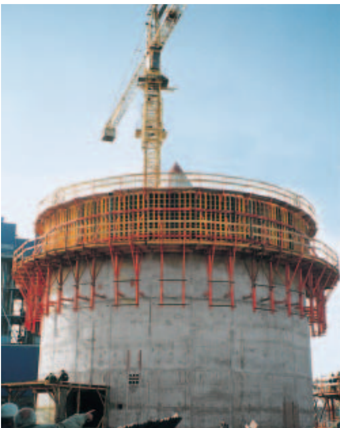
VARIO GT 24 vid bygge av en rund cistern. Tråkilor mellan balkar och ståreglar ger den runda formen
