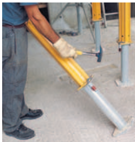
MULTIPROP fot MP 50 är snabbmonterad. Kläm-snabbkopplingen gör detta möjligt.
