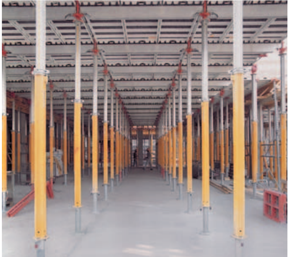
MULTIPROP 350 med fot MP 50 tillsammans med SKYDECK vid formsättning av ett valv med 4,10 m fri höjd.
