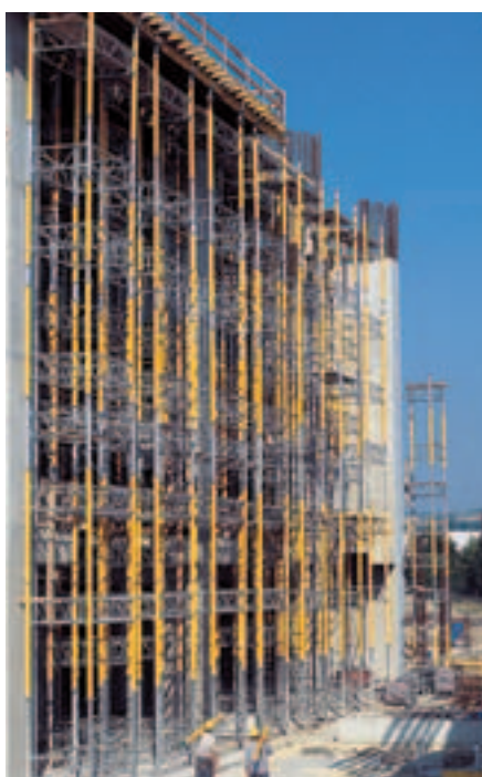
20 m höga MULTIPROP torn som byggnadsställning runt ett utkragande tak.
