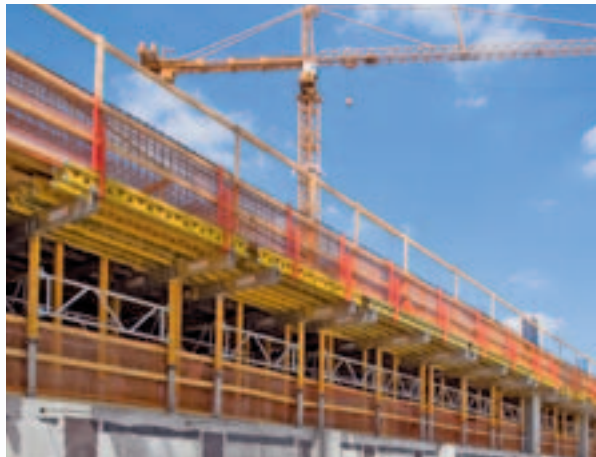
MULTIPROP stämptorn med alubalk MPB som bockrygg och GT 24 som strörbalk.
