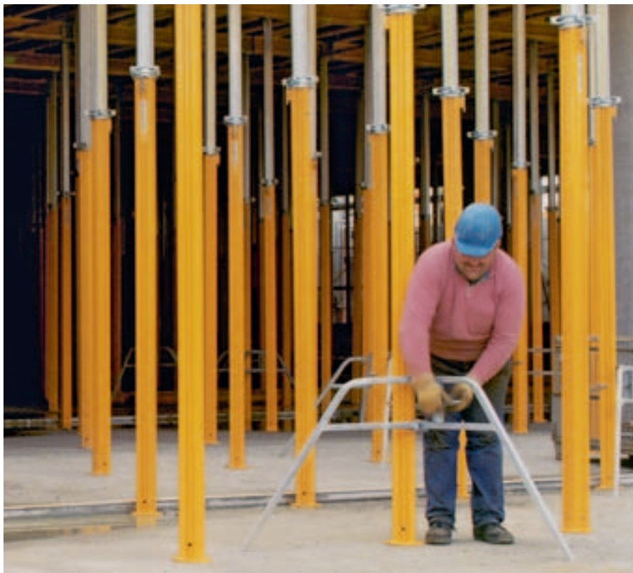
Trebensstödet tjänar som uppställningshjälp. Horisontella laster måste tas upp av konstruktionen via formen.
