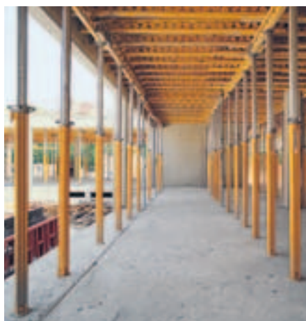
MULTIPROP 350 med valvform MULTIFLEX.
