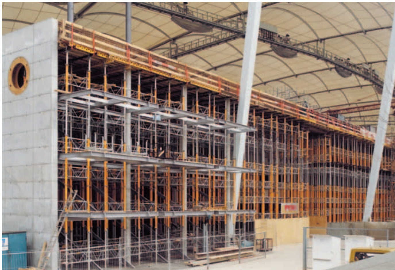
14,00 m högt MULTIPROP stämptorn på en yta på 3.500 m 2 .
