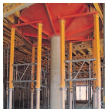
MP 350 med ramar, som stödkonstruktion för formen till ett pelarkapital.
