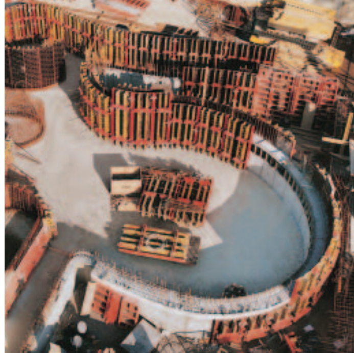
PERI RUNDFLEX vid bygge av ett upplevelsebad. Radier på 1,50 m upp till över 20,00 m formades snabbt.
