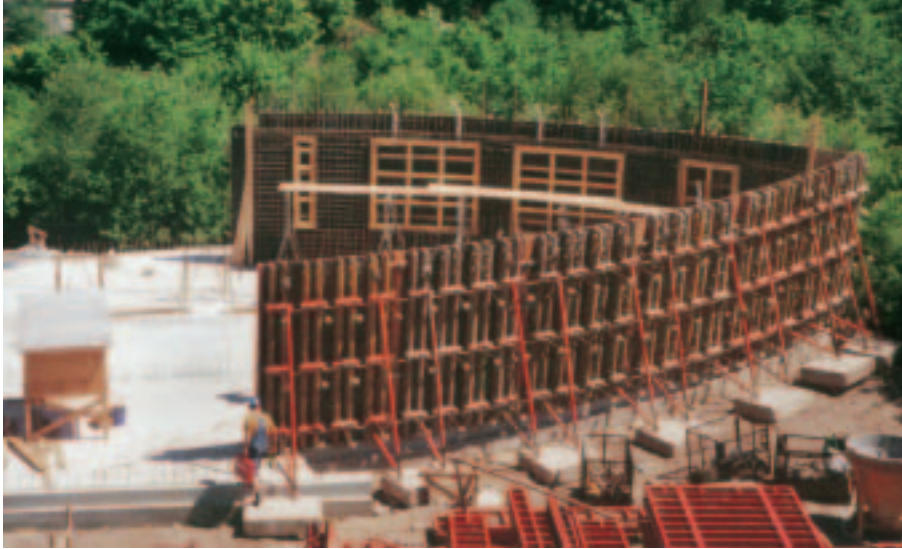
RUNDFLEX vid bygge av ett vårdshus utformat som en fartygsakter. Radien som ändrades ständigt var inte något problem.
