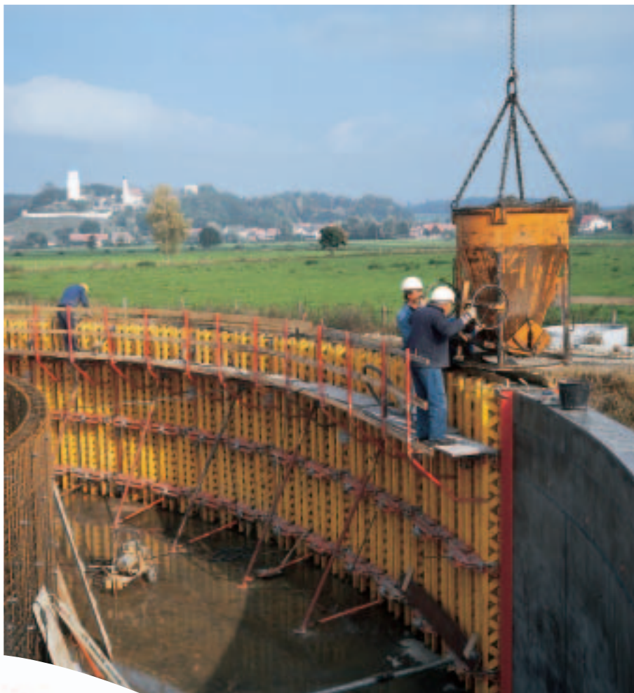
3,60 m hög RUND FLEX formar för olika radier vid byggen av reningsverk.
