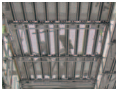
Heltäckt plattform med PERI UP rastersystem
