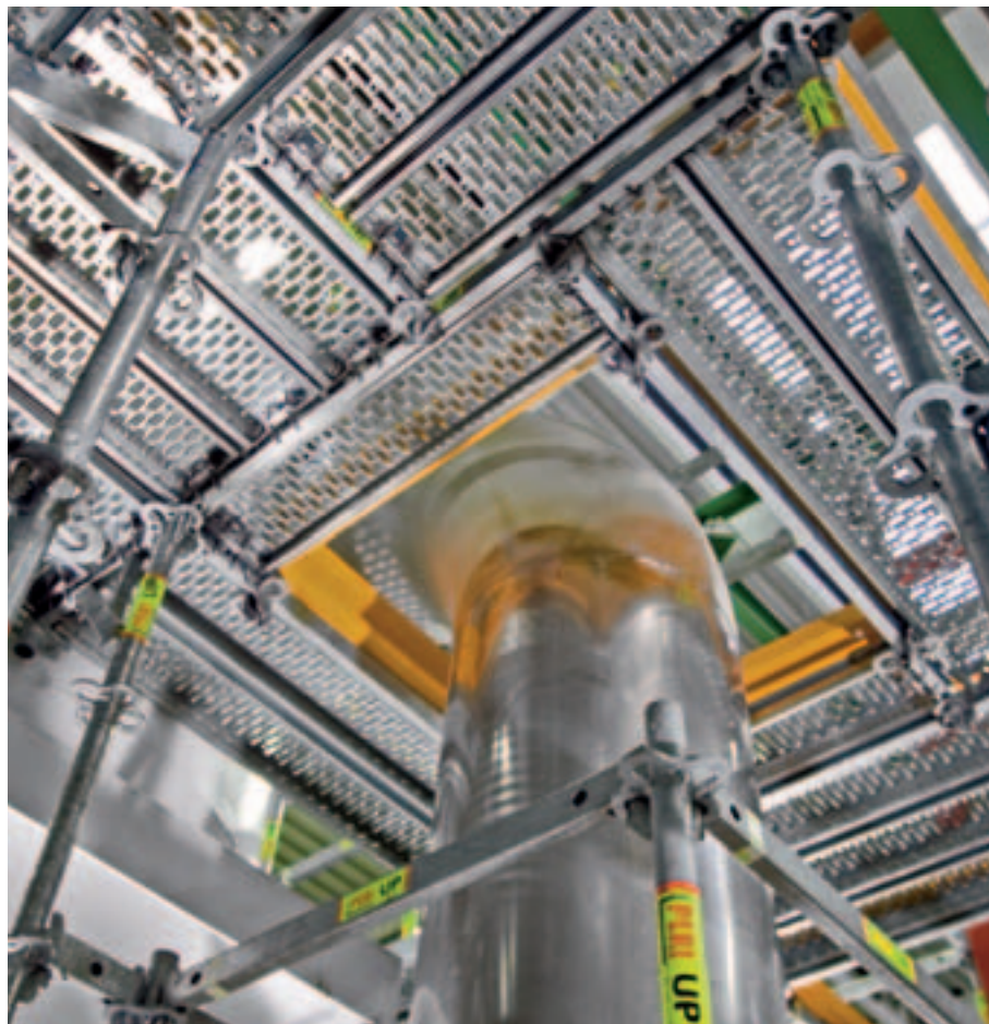
Montering runt rör. Inga problem med PERI kopplingsdelar.
