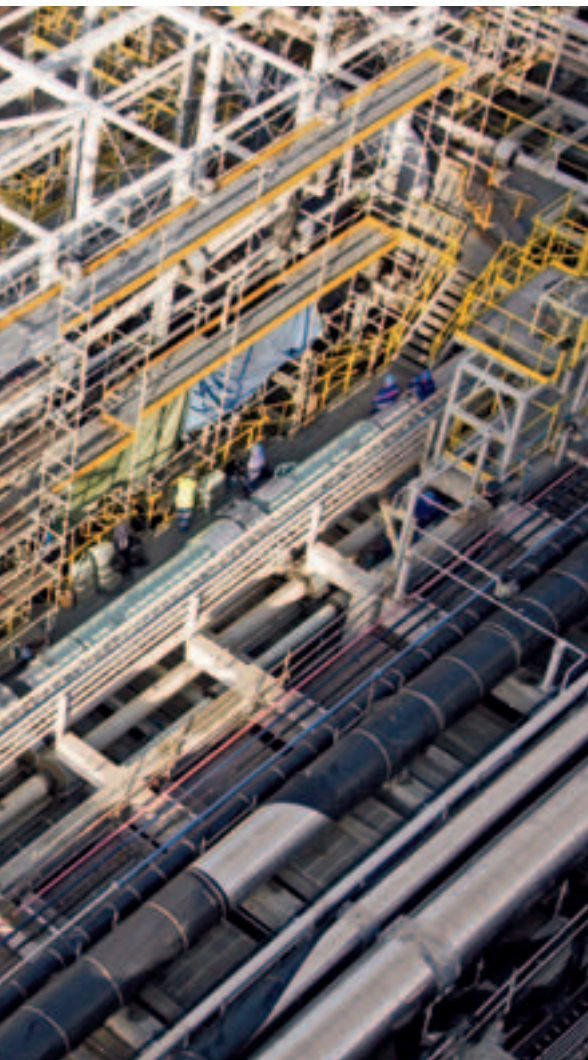
Arbetsplatser för installations- och underhållsarbete monteras snabbt med PERI UP. Stålplan läggs bara ut där det faktiskt behövs.
