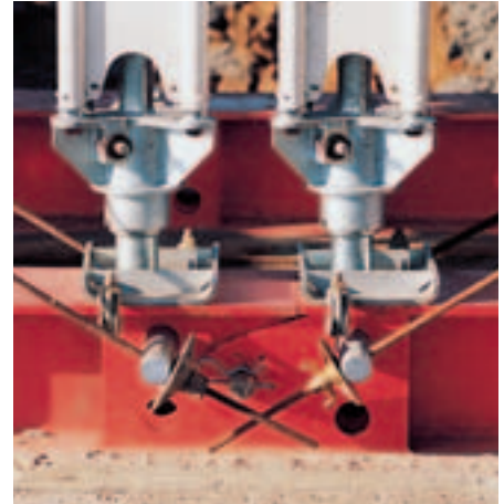
Diagonal förankring med formstag DW 15.
