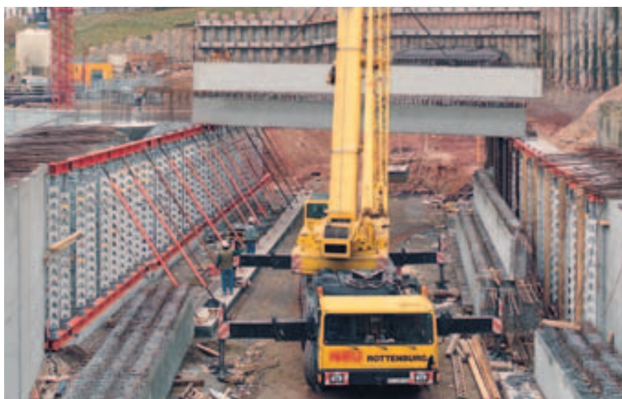
PERI HD 200 som stöd för prefabricerade spännbetongbalkar.
