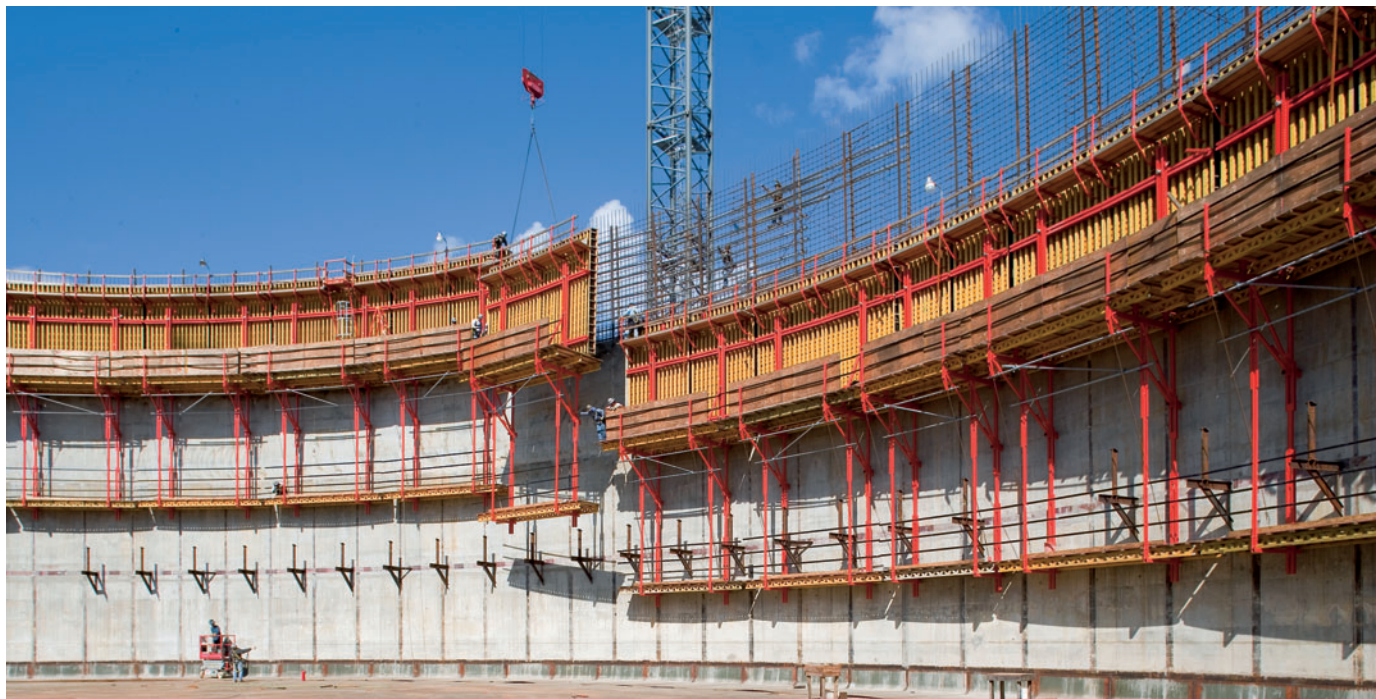
LNG tankar för flytande gas Runda väggar \varnothing 77,50 m med CB 240 och VARIO GT 24.
