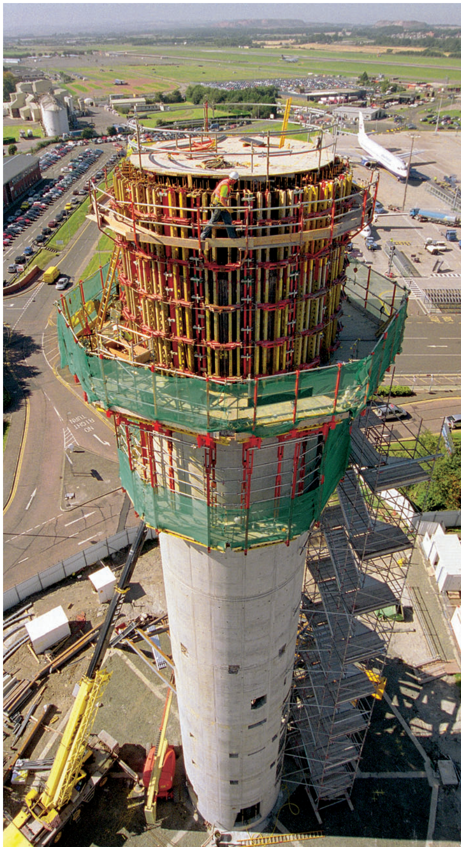
Flygledartorn 46 m högt, \varnothing 6,85 m utvändig. Med PERI RUNDFLEX och konsoler CB 240.
