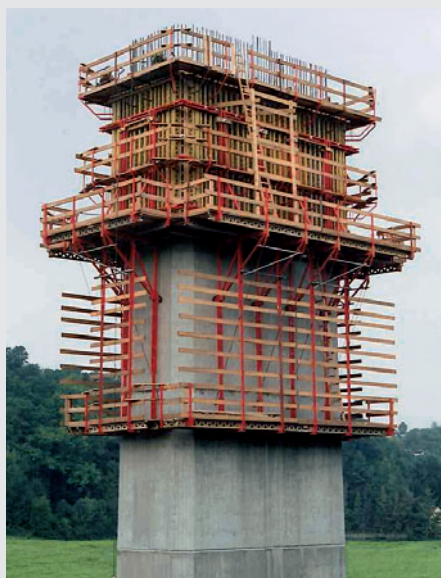
Bropelare Synlig betong med CB 240 och VARIO GT 24.
