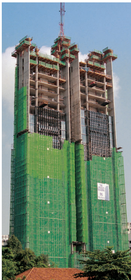
Bostadshus, 30 våningar Konsoler CB 240 och CB 160 med VARIO GT 24.
