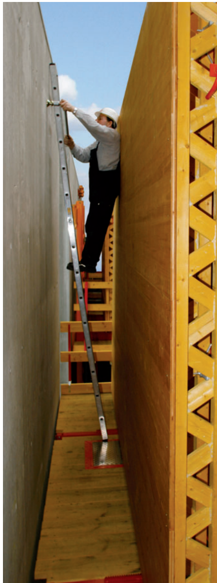
Säkert arbete på CB 240 i skydd av formelementet.
