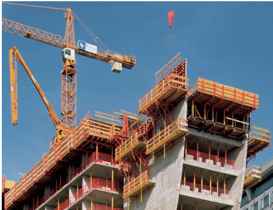
Hotellbygge Konsol CB 240 komplett med hängplattform och TRIO.
