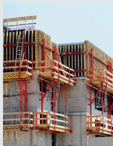
Säkerhet PERI stegar ger säkert till- träde till hängplattformen.
