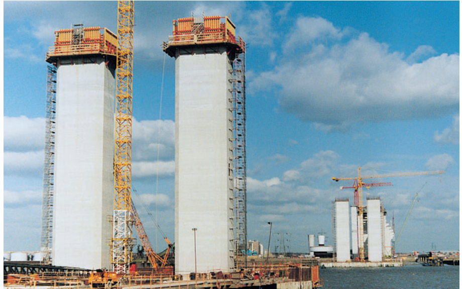
CB 240 med VARIO GT 24 vid bygge av bropelare.
