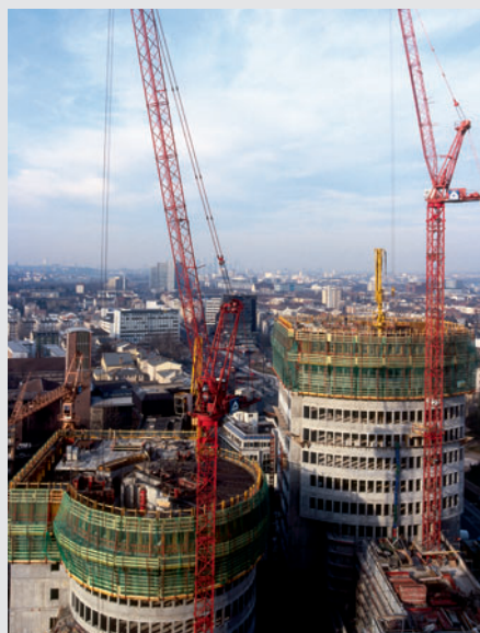
Förvaltningsbyggnad CB 240 med TRIO och VARIO GT 24.
